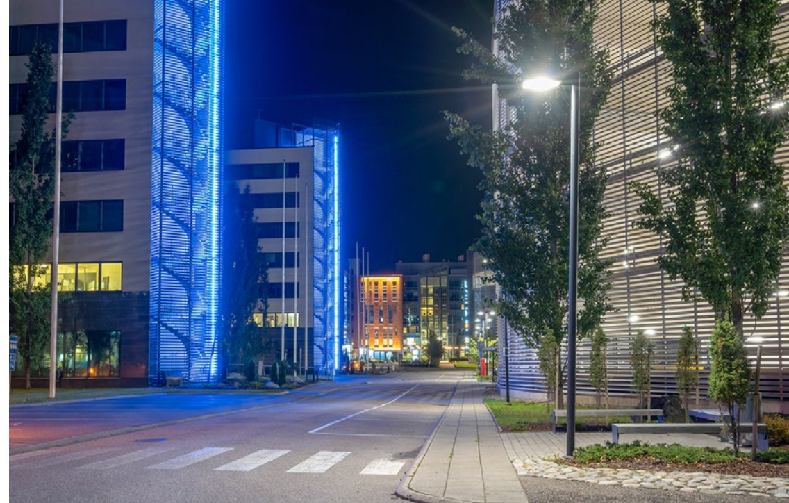
Kuva 14. Esimerkkikuva Äyritieltä, yhtenäinen porraskäytävävalaistus
